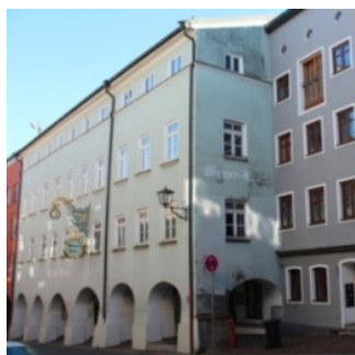
Schmidzeile 7 (Baudenkmal) Ehemaliger Gasthof, Leerstand im EG Abblätterung Anstrich, Schäden am Putz
