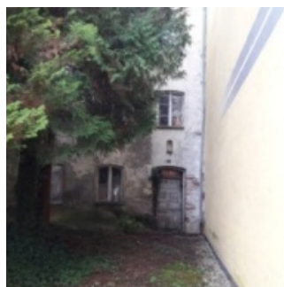
Weberzipfel 7 (bauliche Anlage) Wohnhaus, leerstehend mit erheblichem Sanierungsbedarf
