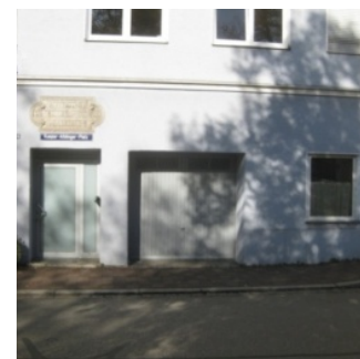
Kaspar-Aiblinger-Platz 34 (ortsbildprägender Bau) EG-Zone mit Kunststofftür, Metalltor und Einscheibenfenster (wenig harmonisch)
