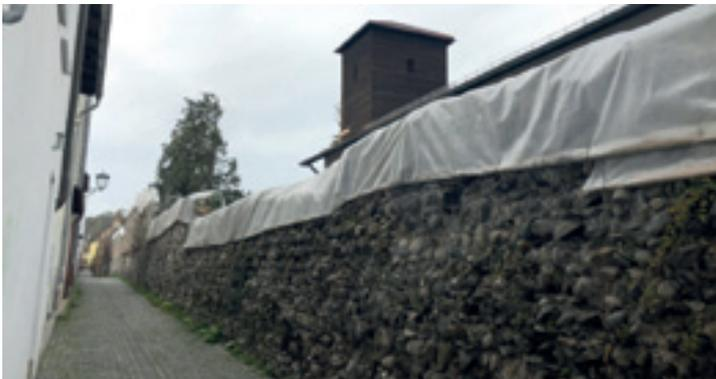
Damit kein Regenwasser eindringt und die Mauer noch mehr schädigt, sind Teile der Stadtmauer vorübergehend mit einer Plane abgedeckt.
