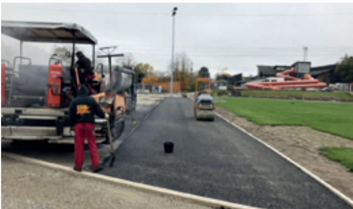
Schweres Gerät ist bei der Sanierung des Badria-Stadions im Einsatz. Aber keine Angst; der harte Asphalt dient nur als Unterbau für die noch folgenden, weichen Kunststoffbeläge der Laufbahnen und Leichtathletikanlagen. Im Hintergrund zu erkennen ist einer der neuen Flutlichtmasten
