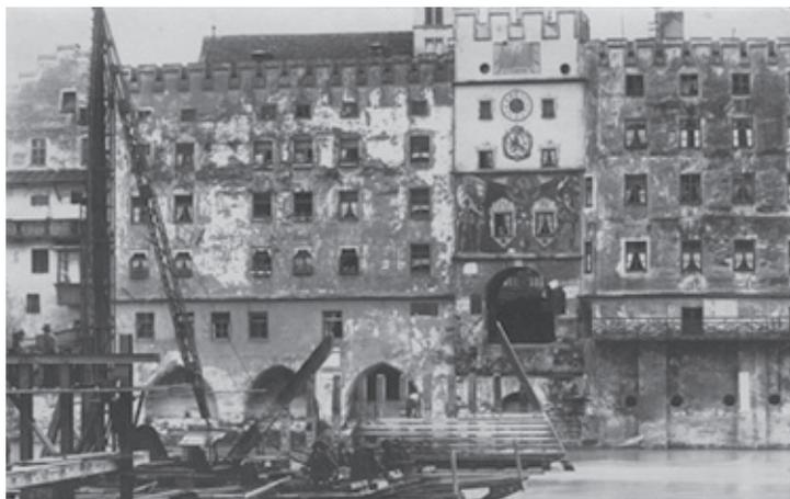
In der Nacht vom 17. auf den 18. März 1929 stürzte die Innbrücke nach einem Eisstoß am 8. März teilweise ein und wurde anschließend neu errichtet, jetzt zum ersten Mal unter Verwendung von Stahl und Beton. Die Wiedereröffnung fand schon am 4. August desselben Jahres statt. Das Foto des Bildarchivs zeigt die Bauarbeiten.
