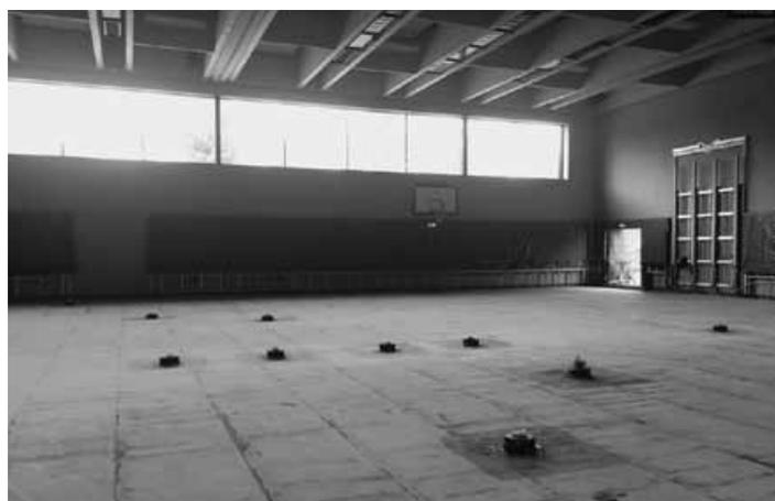
Bis auf den rohen Beton musste der Boden rückgebaut werden
