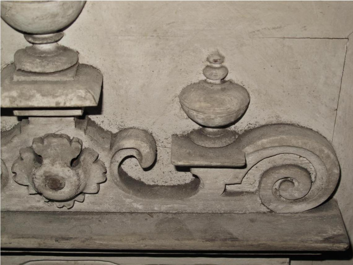
**Abb. 28:** Raum 2, Schrank 2, Ausschnitt linke Türe, Vorzustand: besonders auf den horizontalen Flächen lagen teils dicke Staubschichten. Grauer Rußfilm auf allen Oberflächen.
