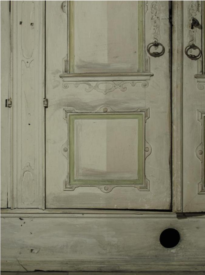
**Abb. 30:** Raum 2, Schrank 3, Zwischenzustand während Reinigung: Rechts Vorzustand. Links nach Abnahme des anhaftenden Rußes mit Trockenreinigungsschwämmen.
