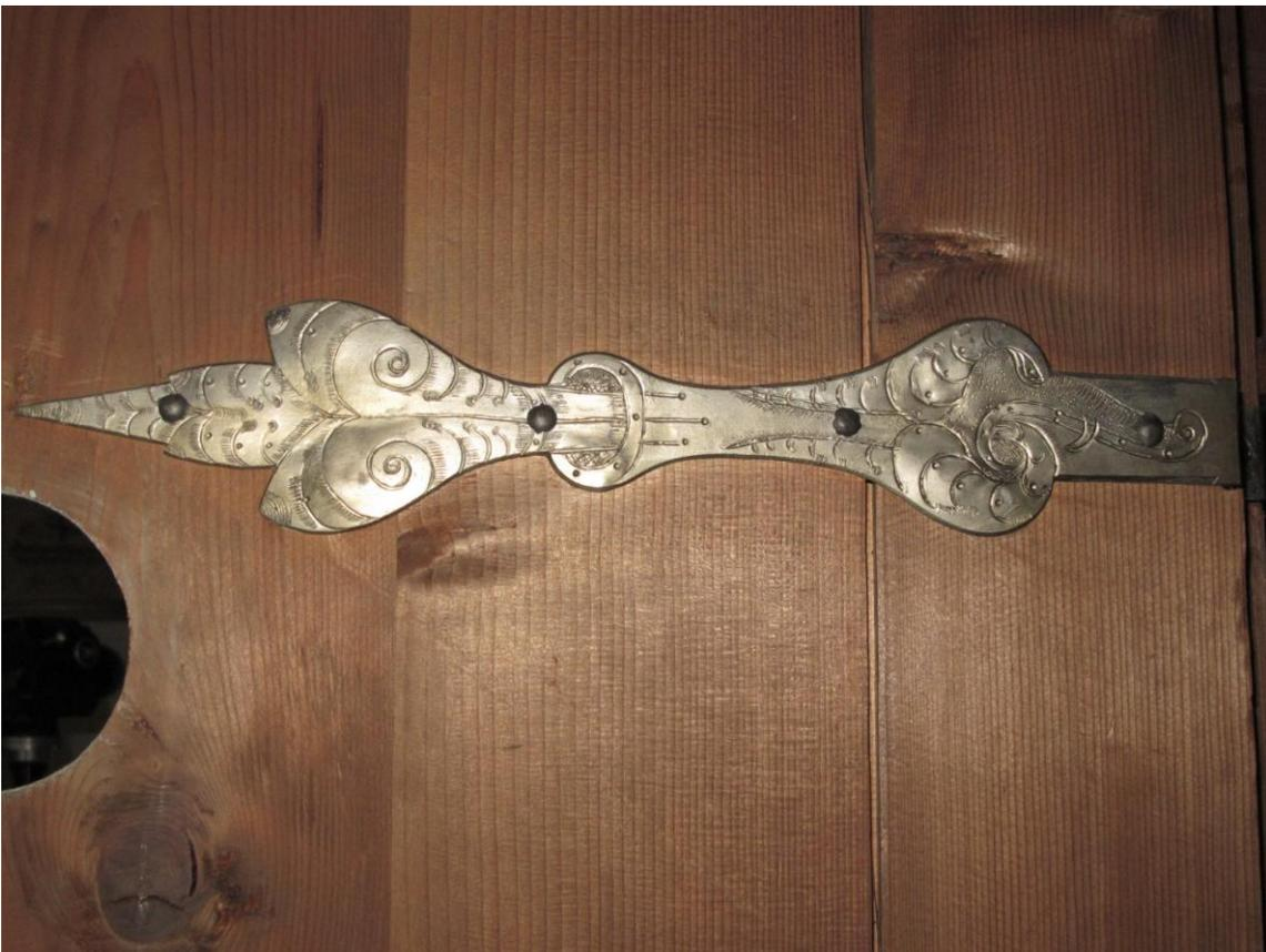
**Abb. 24:** Raum 2, Schrank 6, Band linke Türe, Endzustand nach der Konservierung 2015. Die Oberfläche ist mit geschroteten Linien und Punktpunzierungen verziert, verzinkt und mit einem Schutzüberzug versehen (möglicherweise Leinöl).
