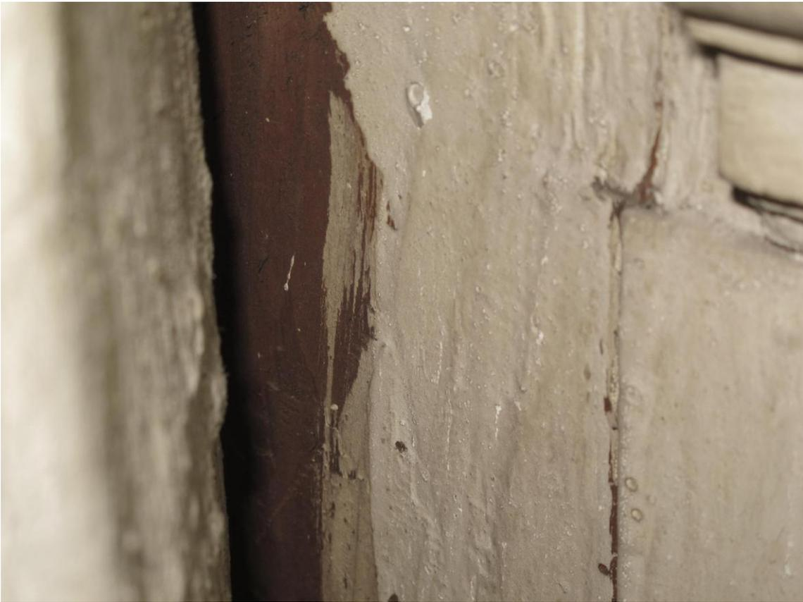
**Abb. 26:** Raum 2 Schrank 1. Im Wandanschluss wird der zweischichtige Aufbau des Anstrichs sichtbar: auf einer grau-gelblichen Grundierung liegt ein weißer, matter Anstrich.
