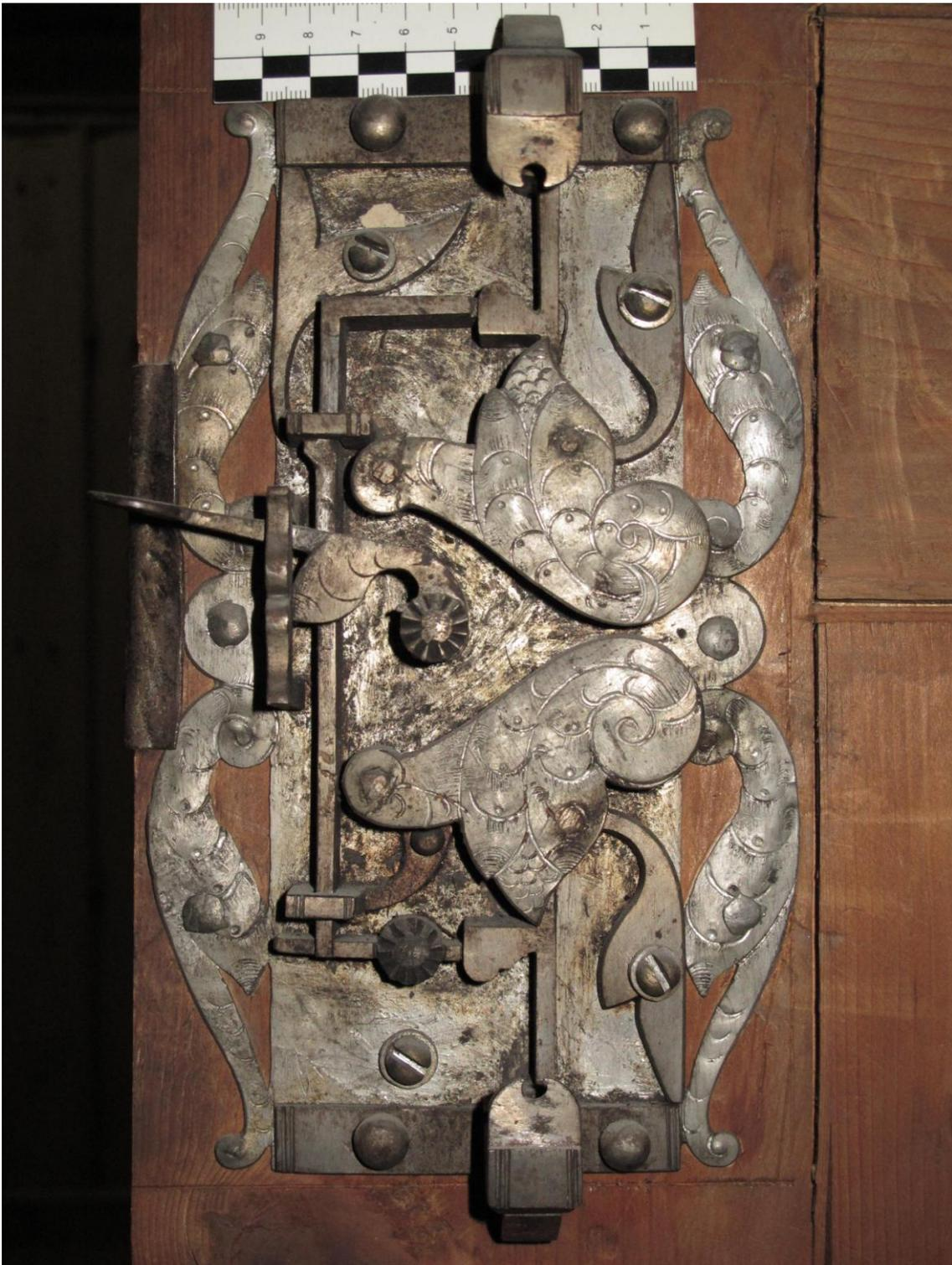
**Abb. 25:** Die Ausführung der Schlösser ist unterschiedlich. Möglicherweise fand ein Altbestand Verwendung.
