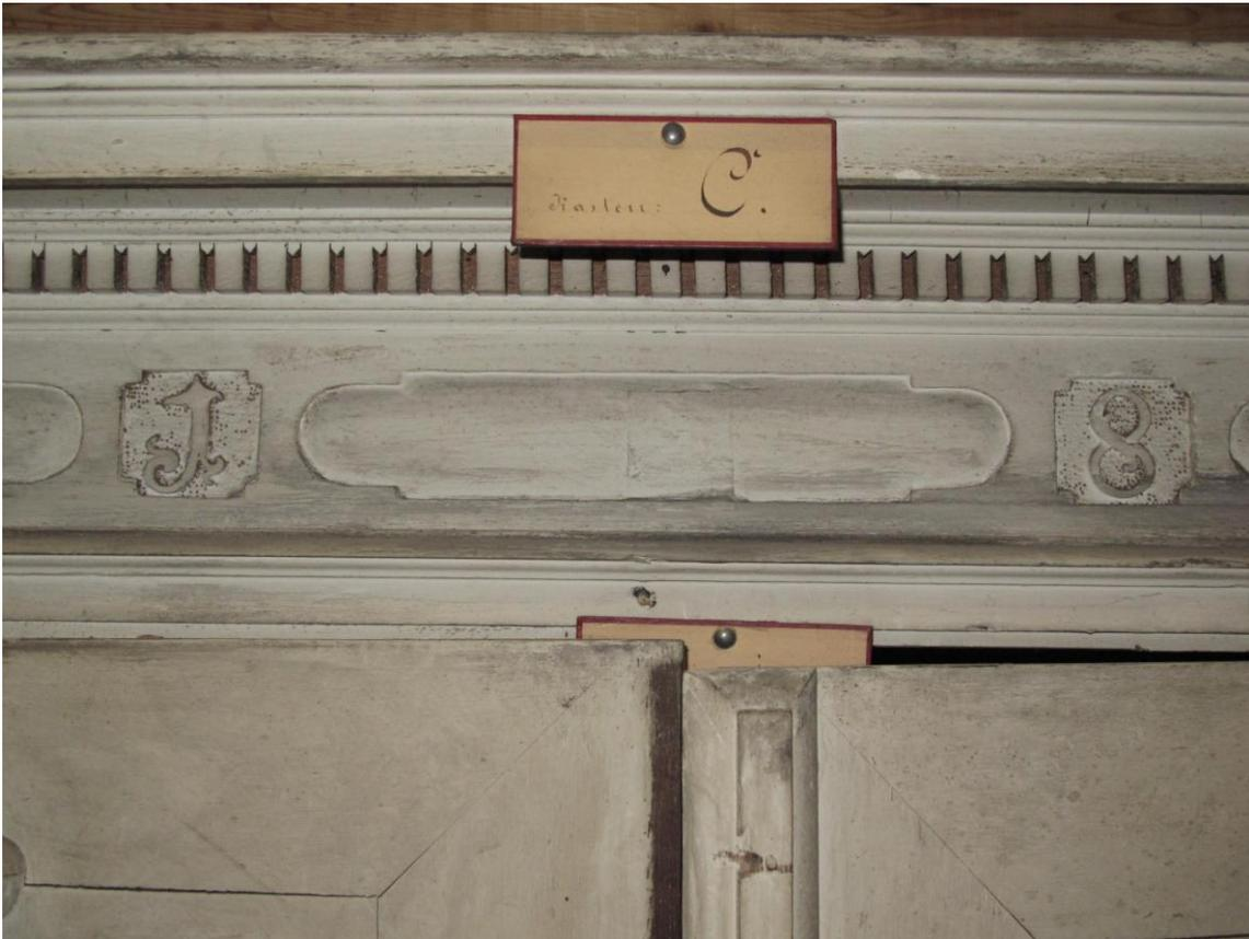
**Abb. 20:** Raum 2 Schrank 3: Im Gesims ausgesägte und applizierte Jahreszahlen. In den Flächen dahinter wurde das Holz mit Punktpunzen strukturiert.
