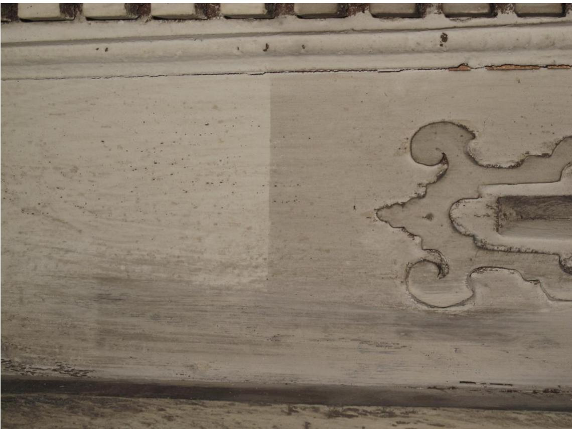
**Abb. 13:** Raum 2 Schrank 1, Zwischenzustand Oberflächenreinigung: Rechts Vorzustand mit aufliegendem Ruß. Mitte Zustand nach Abnahme des anhaftenden Rußes mit Trockenreinigungsschwämmen. Links Zustand nach Reduzierung des eingeriebenen Rußes mit speziellen Radiermaterialien (Endzustand der Oberflächenreinigung).
