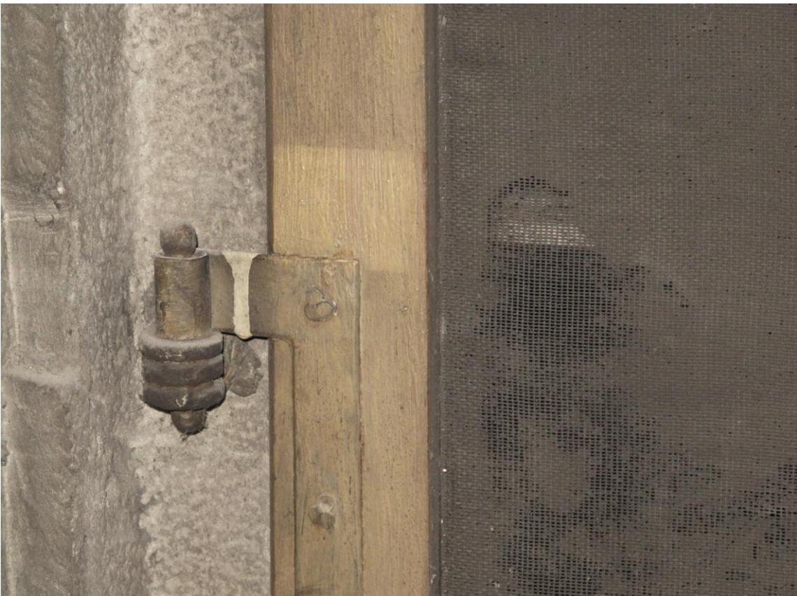
**Abb. 29:** Raum 2, Ausschnitt Fenster: Arbeitsprobe zur schwach feuchten Oberflächenreinigung am Rahmen. Im Umfeld liegt auf dem Rahmen, dem Steingewände und dem Gitter noch die Rußschicht.
