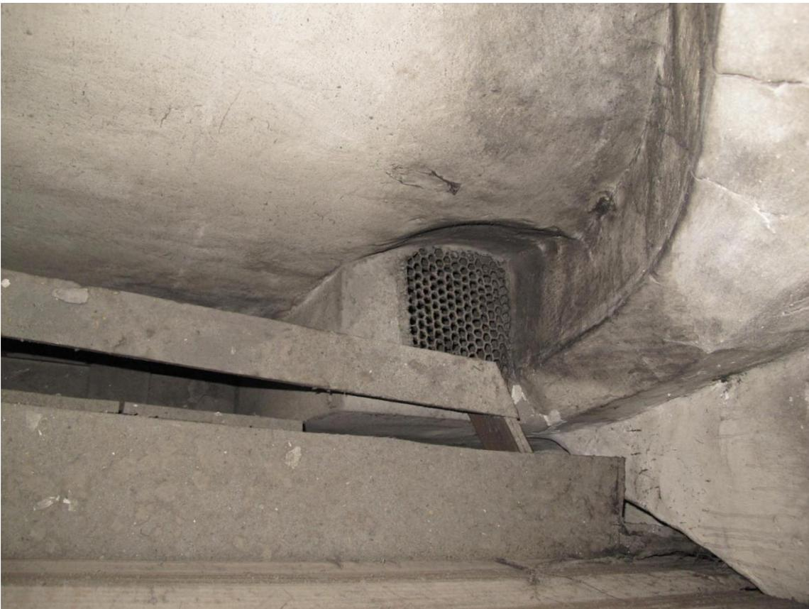
**Abb. 22:** Raum 2, Aufsicht auf Öffnung des Heizungsluftschachtes hinter Schrank 7 (rechts in der Ecke), aus dem höchstwahrscheinlich der Ruß die Räume durchströmte.
