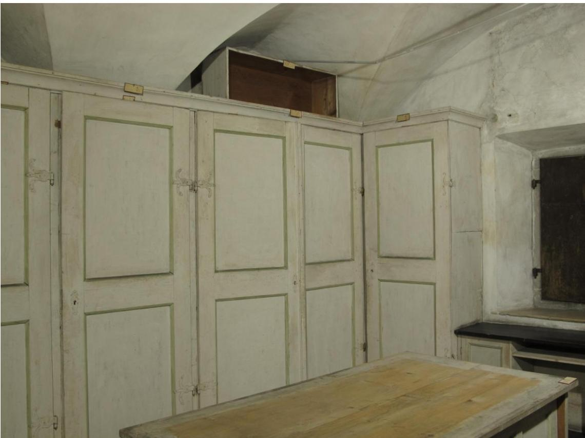
**Abb. 11:** Endzustand April 2015 nach Fassungsfestigung, Oberflächenreinigung und minimaler Retusche zur Integration störender Flecken und Fehlstellen.
