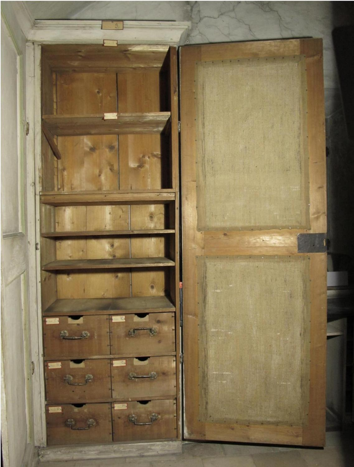
**Abb. 9:** Raum 1, Schrank 6 innen: Die Leinwand wurde mit Nägeln aufgespannt und zusätzlich mit Leim fixiert. Vorzustand 2013 mit Verschmutzungen.
