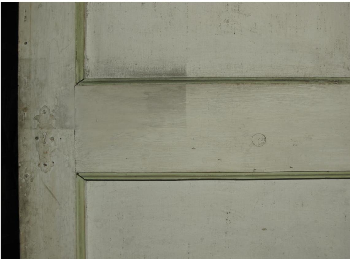
**Abb. 15:** Raum 1 Schrank 5, Zwischenzustand nach Abnahme des anhaftenden Rußes und während der Reduzierung des eingeriebenen Rußes mit Radiermaterialien.
