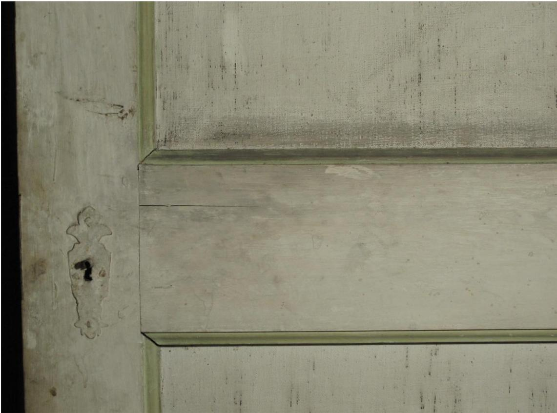
**Abb. 14:** Raum 1, Ausschnitt Schrank 6, Vorzustand: entlang des Profils wurde der Ruß durch feuchtes Wischen wie eine dunkle Pigmentierung in die Farben gerieben.
