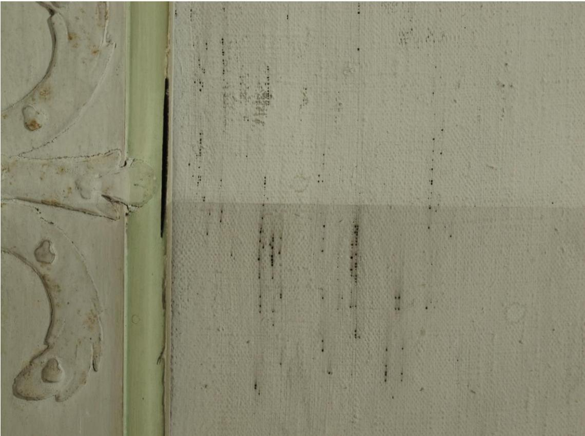
**Abb. 12:** Raum 1 Schrank 3, Zwischenzustand während Reinigung. Unten Vorzustand mit Rußschaden. An den kleinen Löchern im Anstrich ist der Ruß in Fahnen nach oben gezogen.
