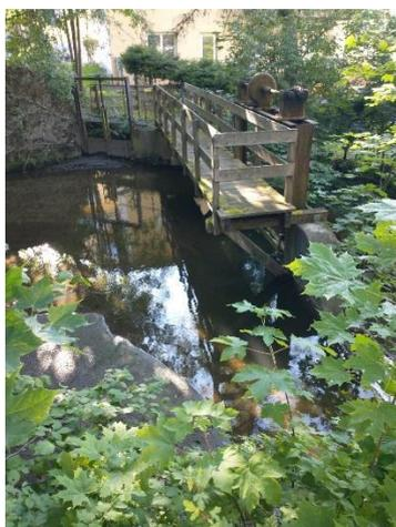
**Foto 04:** Wehr und Ableitung des Mühlbaches an der ehemaligen Walkmühle.
