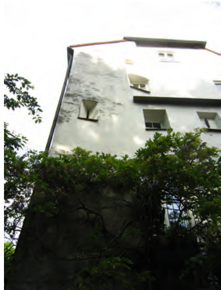
11 Ecksituation / Turm Nordwestecke mit Schar- tenöffnung (Aufnahme 2018).
