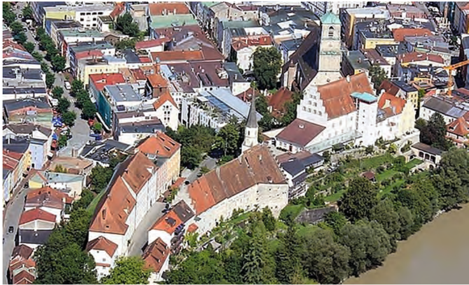
4 a Burganlage Wasserburg von Südwesten. Im Vordergrund die Vorburg mit innseitigem Kastengebäude, dahinter anschließend die Kapelle und das Schloss, dahinter die Pfarrkirche St. Jakob.
