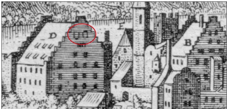
46 b Lokalisierung der Wappenfelder in der Ansicht der Burg 1644. Dass es sich tatsächlich um die Wappenfelder handelt und nicht etwa um Fensteröffnungen, wird dadurch verdeutlicht, dass die beiden Flächen im Gegensatz zu den Fenstern nicht ausgefüllt sind.
