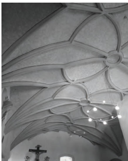
27 Schloss, Gewölbe Mittelflur 2. Obergeschoss, Blick nach Norden / Richtung Stadt (Aufnahme 2016).
