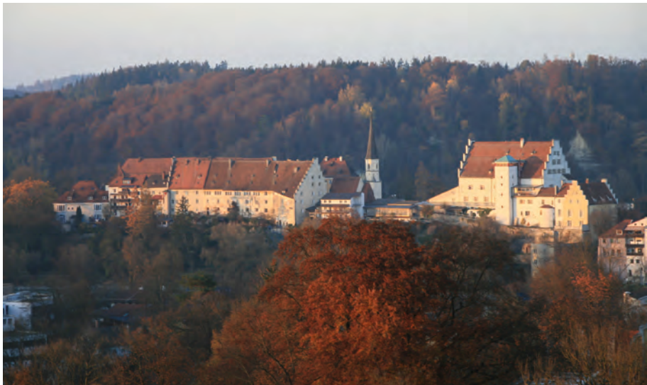
6 Die Burganlage von Südosten / Anhöhe Achatzberg aus gesehen, links der langgezogene Baukörper des Kastens, rechts an höchster Stelle das Schloss (Aufnahme 2018).
