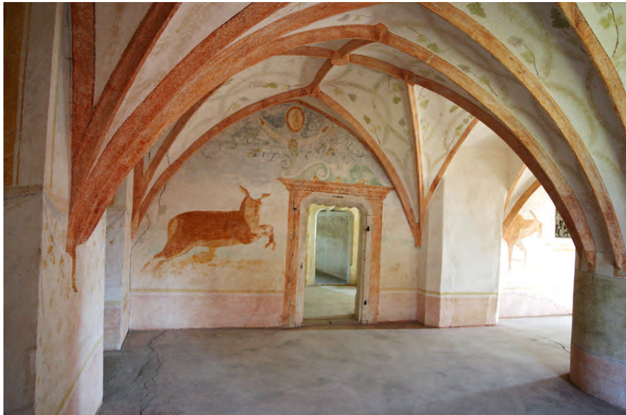
56 a Ausmalung der Tafelstube im ersten Obergeschoss von Schloss Grüna, begonnen 1530, Blick nach Norden (Aufnahme 2003) (vgl. Abb. 56 b).
