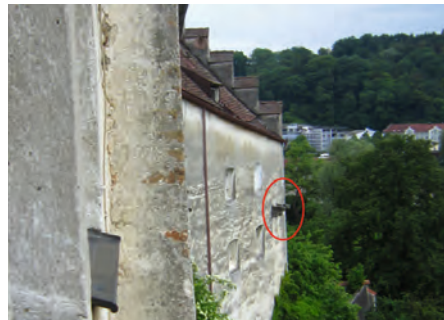
43 b Konsolsteine an der Südseite des Kastens (Aufnahme 2016).
