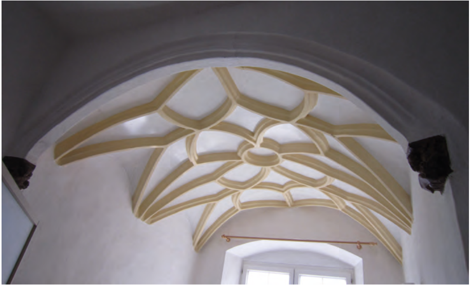
60 a Gewölbe und Konsolen im Osterker 1. Obergeschoss (Aufnahme 2016).
