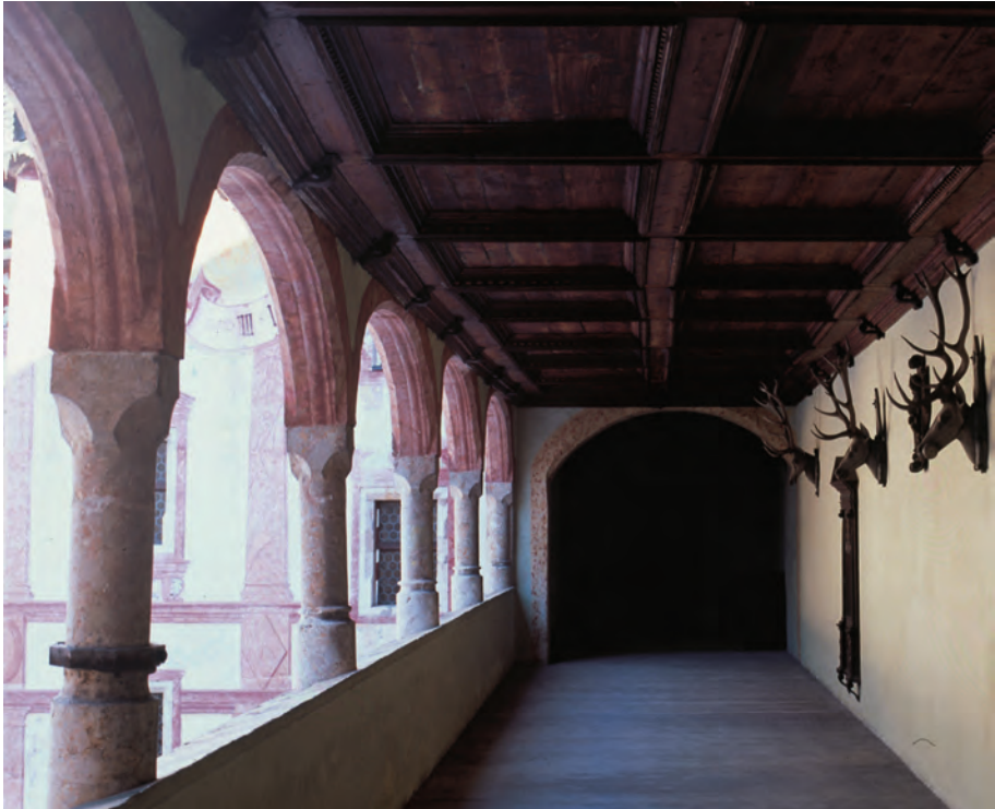
62 b Arkadengang im zweiten Obergeschoss des Innenhofs von Schloss Tratzberg.
