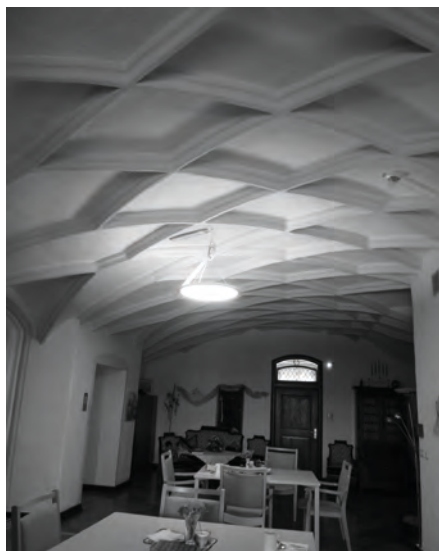
26 Schloss, Gewölbe Mittelflur 1. Obergeschoss, Blick nach Norden / Richtung Stadt (Aufnahme 2016).
