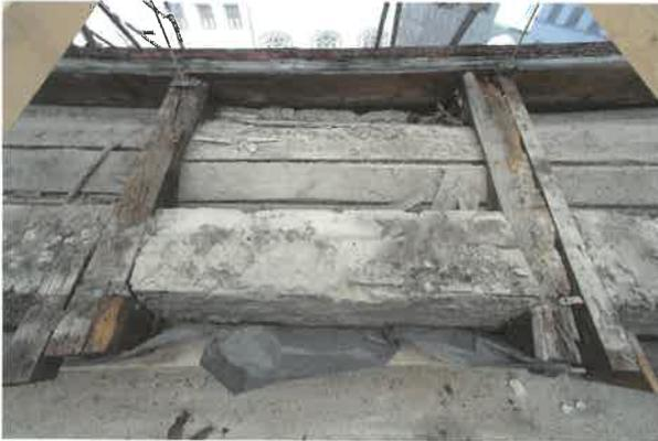
BIS HEUTE ERHALTENE DACHKONSTRUKTION ÜBER DEM FASSADENBEREICH DES KERNHAUSES. HIER GUT ZU ERKENNEN: DIE AUCH IM MODELL („EISSEN HÄCKHEN“) EINGEZEICHNETEN METALLRIEGEL / SCHLAUDERN ZUR SICHERUNG DER VERBINDUNG VON DACHWERK UND MAUER.
