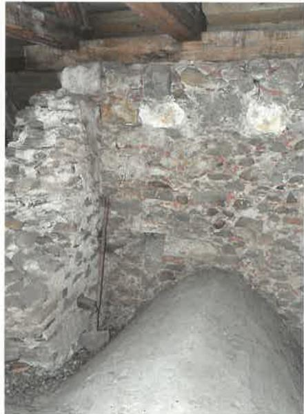
CHOR, DACHRAUM, NORDWESTECKE. WESTWAND MAUERWERK DER BAUPHASE II (2. H. 14. JH.). NORDWAND MAUERWERK DER BAUPHASE III (1538), MIT ABRUCHMATERIAL, BRUCHSTEINE MIT MALEREIRESTEN (PFEILE). DIE WESTWAND LÄUFT HINTER DIE NORDWAND.
