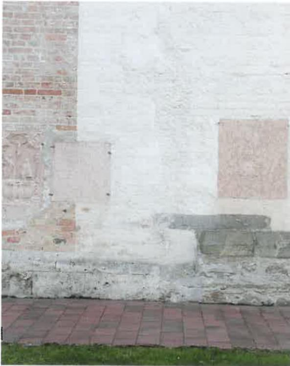
Abb. 11: Nordfassade, Baunaht zwischen Langhaus und Turmjoch.
