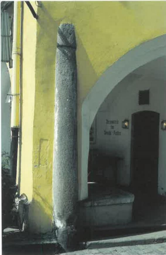
Abb, 7: Granitsäule als vermutlicher Träger des auszuhängenden Marktzeichens. Die ab Bodenniveau 3,5 m hohe Säule ist an den Ecken abgefast, hat unten 88 cm Umfang und verjüngt sich nach oben. Auf der Höhe 1,55 m ist eine Einstecköffnung von 12 mm Durchmesser, bei 3,30 m eine weitere mit 20 mm. So ist durchaus vorstellbar, daß hier einmal ein Haken zum Einstecken des Marktzeichens angebracht war.
