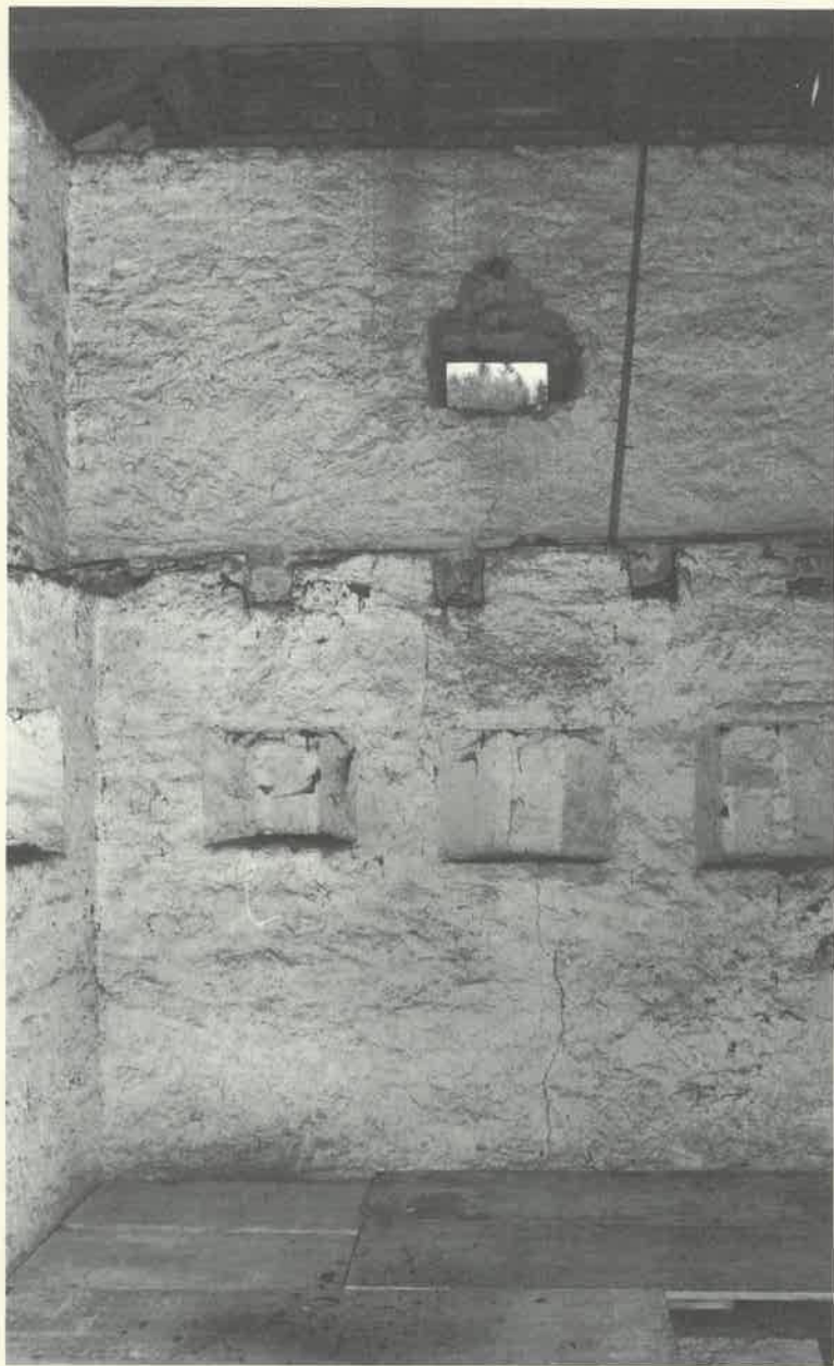
Abb. 25: Vermauerte Schießscharten in der Westwand des 1. Stockwerks. Die Zwischendecke fehlt, das querformatige Fenster im 2. Stockwerk ist sekundär.
