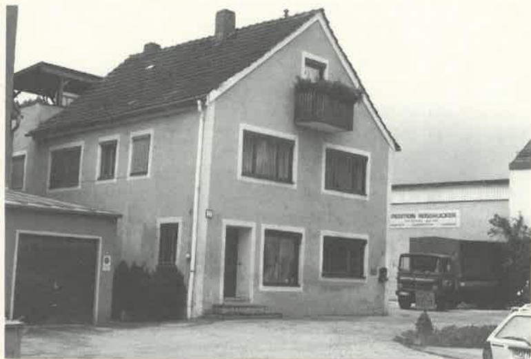
Abb. 10: Der ehemalige Totengräberturm an der Stadtmauer, dessen Bausubstanz noch im Wohn- und Bürogebäude der Fa. Rossrucker erhalten ist. Die Aufnahmeorientierung entspricht in etwa der Zeichnung Treleanos.
