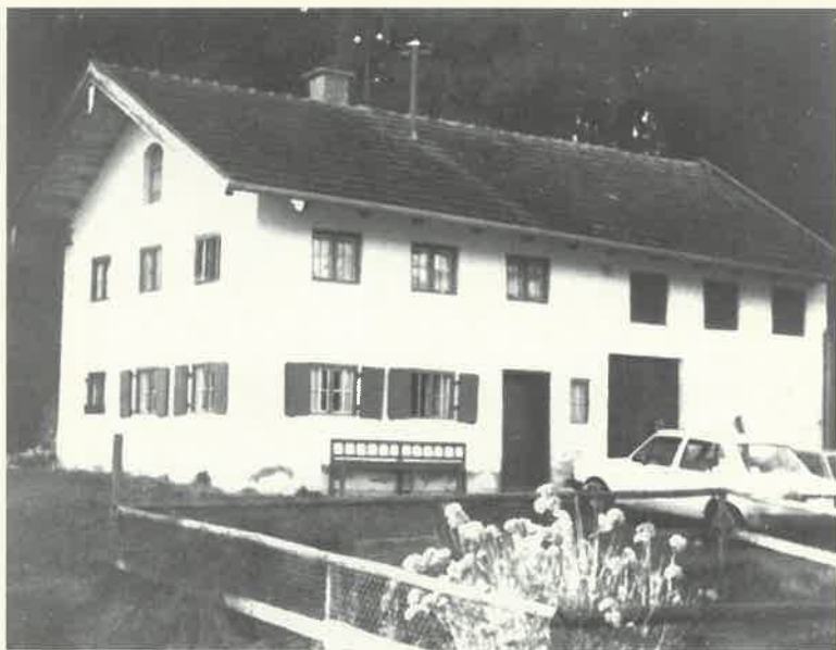
Abb. 5a: Zustand des Weiherhauses vor dem Abbruch.
