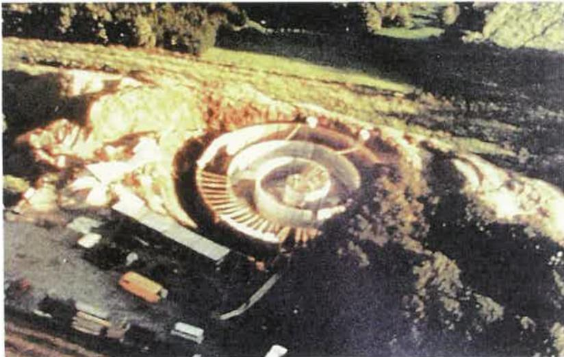
Abb. 40: Hochbehälter III (Spiralleitwand-Behälter) im Bau
