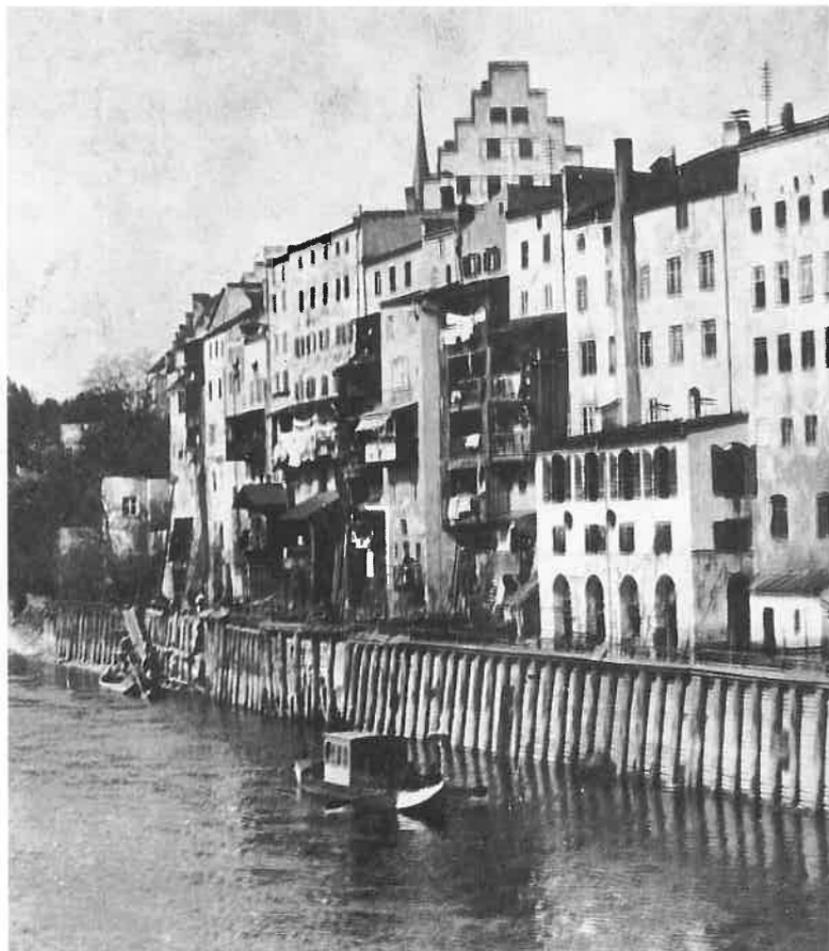
Abb. 37: Die sog. Archen, Uferverbauungen an der Innfront.
