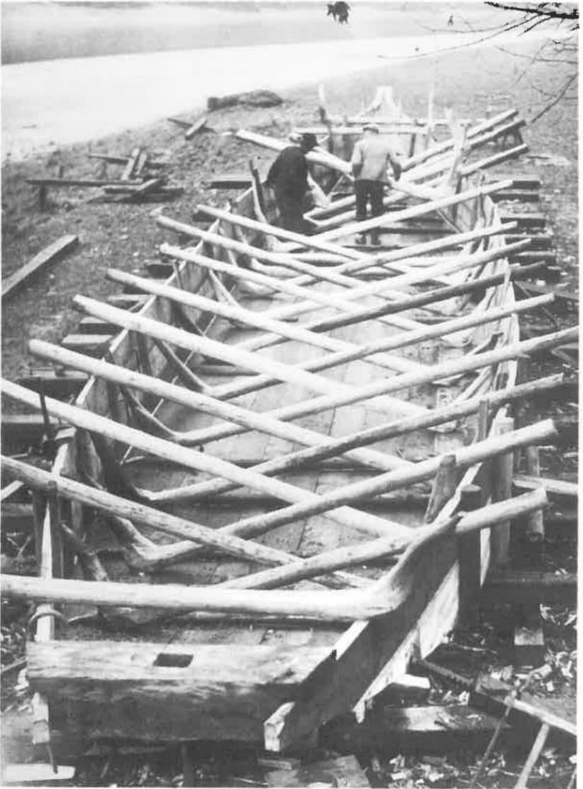
Abb. 7: Das wechselseitige Verteilen der Kipfen. Die schwächeren Kipfen kommen an die beiden Schiffsenden, die stärkeren in die Mitte. Die Kipfenhörndl müssen von der Mitte ab jeweils gegen das Ende der Platte schauen.
