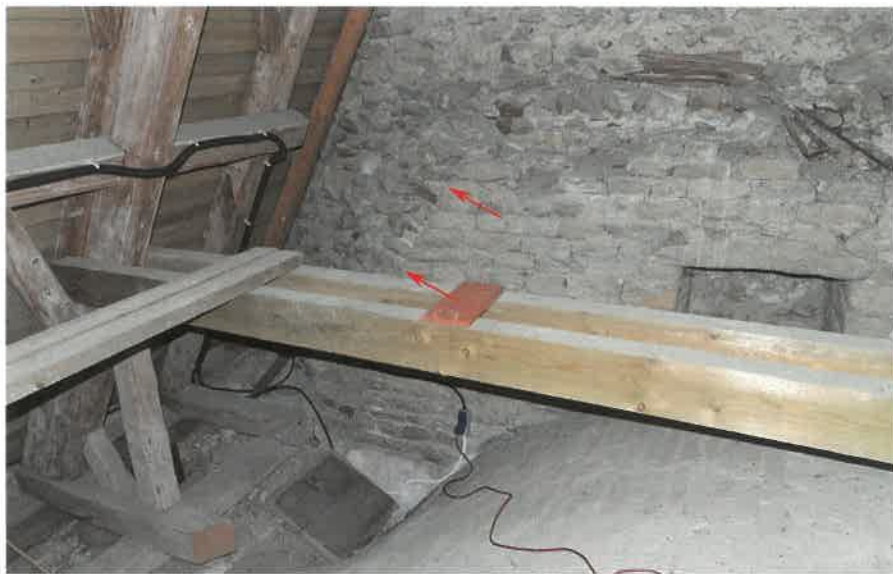
LANGHAUS, DACHRAUM, WESTGIEBEL, SÜDLICHER TEIL. IM UNTEREN TEIL KLEINFORMATIGES BRUCHSTEINQUADERMAUERWERK DES ROMANISCHEN BAUS MIT ANSATZ EINES GEWÖLBES (PFEILE) UND VERMAUERTEM EMPORENZUGANG. MAUERWERK DARÜBER BAUPHASE II (2. H. 14. JH.).
