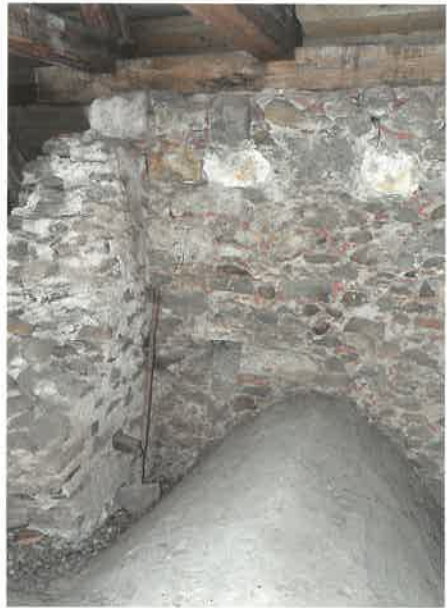
CHOR, DACHRAUM, NORDWESTECKE. WESTWAND MAUERWERK DER BAUPHASE II (2. H. 14. JH.). NORDWAND MAUERWERK DER BAUPHASE III (1538), MIT ABBRUCHMATERIAL, BRUCHSTEINE MIT MALEREIRESTEN (PFEILE). DIE WESTWAND LÄUFT HINTER DIE NORDWAND.
