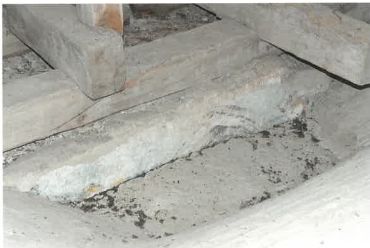
LANGHAUS, DACHRAUM, SÜDWAND, ZWICKEL ZWISCHEN 1. UND 2. JOCH VON OSTEN. JÜNGSTES GERICHT.
