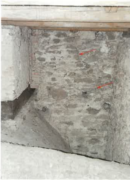
CHOR, DACHRAUM, OSTWAND, SÜDLICHER TEIL. IM UNTEREN TEIL MAUERWERK DER BAUPHASE II (2. H. 14. JH.), DAS EINEN STEILEN GIEBEL AUSBILDET (PFEILE). ERHÖHUNG DES GIEBELS IN BAUPHASE III (1538).
