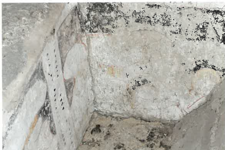
LANGHAUS, DACHRAUM, NORDWAND, ÖSTLICHER ZWICKEL. OSTWAND, WOHL GEFANGENNAHME.
