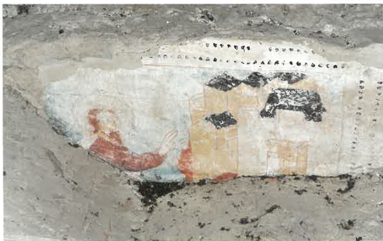
BEIDE ABBILDUNGEN: LANGHAUS, DACHRAUM, NORDWAND, ZWICKEL ZWISCHEN 1. UND 2. JOCH VON OSTEN. LINKS EINZUG IN JERUSALEM, RECHTS NICHT IDENTIFIZIERTE SZENE.
