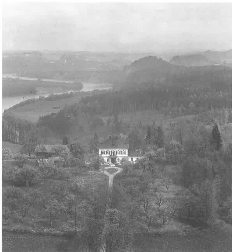
Abb. 4: Das Hesse-Schlössl mit umgebenden Obstgartenanlagen; Luftaufnahme von Süden.
