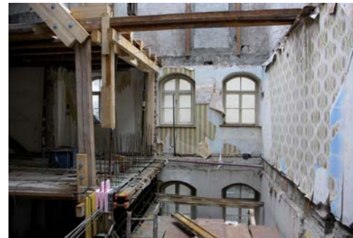
⑦ Neu „eingepasstes“ zentrales Treppenhaus während des Baus
