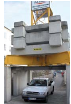
⑧ Durchfahrt unter Kran
