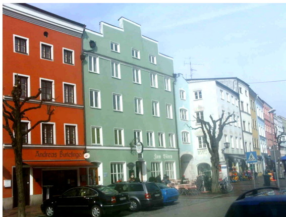
Sanierte Häuser in der Altstadt
